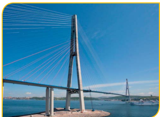
Vue générale du pont, le 27 juillet 2012. http://rusmost.ru/
