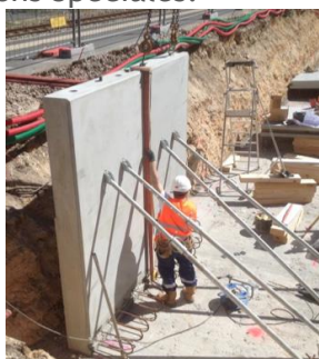
Préparation et pose des rampes
