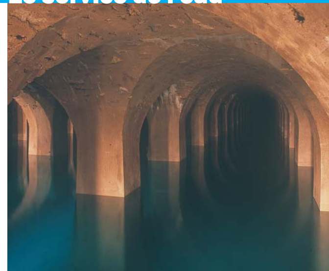
Réservoir de Montsouris, Paris 14 e © Eau de Paris
