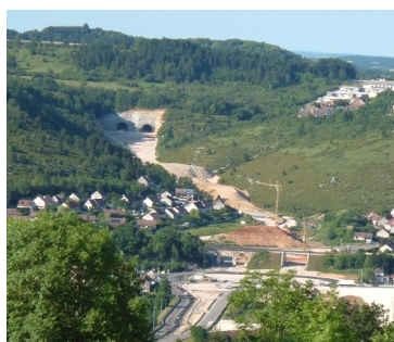
Chantier de la LiNo (crédits photos : DREAL Bourgogne)
