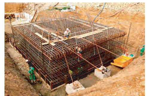
Ferrailage de la semelle
