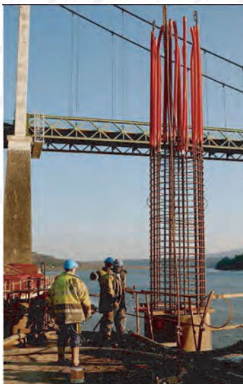
Mise en place de la cage d'armature
