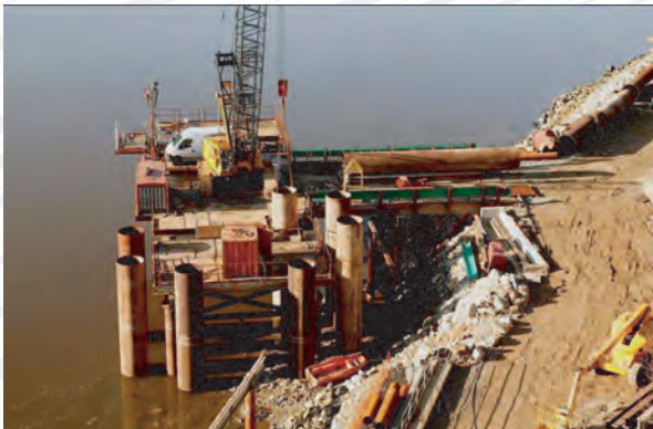
Mise en place des gaines
