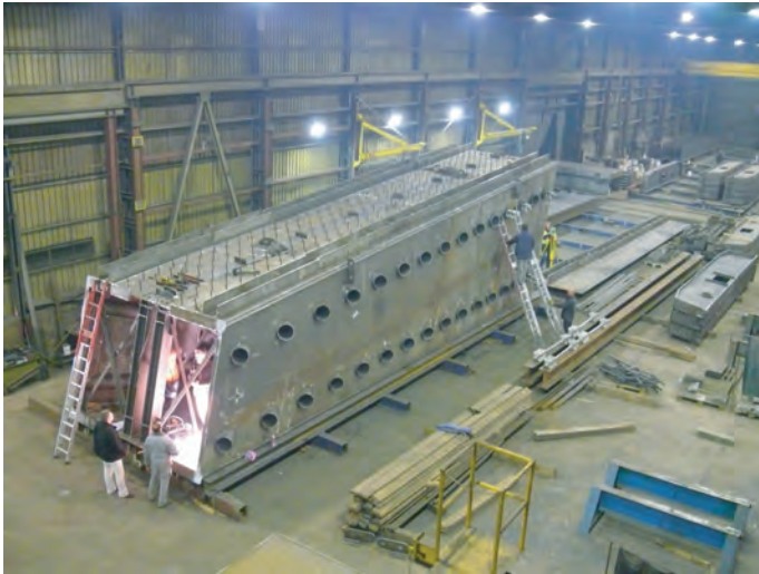
Construction d'une boîte d'ancrage en atelier.
