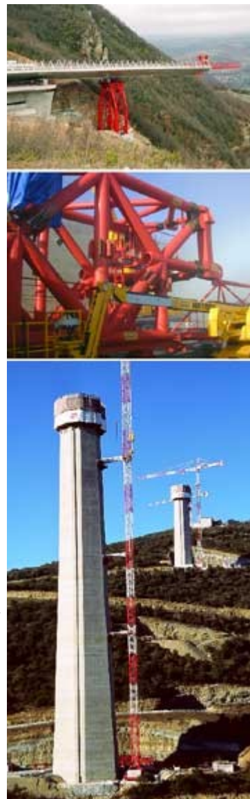
En haut : 1ère phase (L1) du lancement. Au milieu : l'équipage de poussage. En bas : la pile P2 en cours de construction à plus de 100m de hauteur (photos Eiffage)
