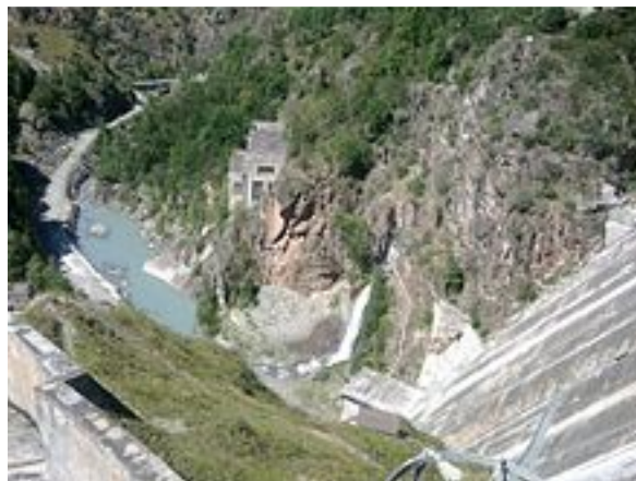
L'aval du barrage.
