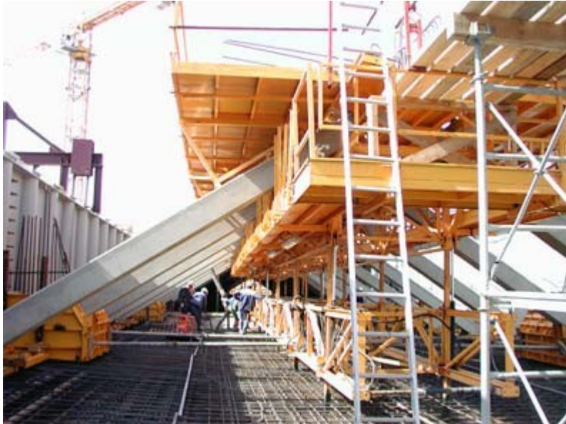
(Pose des bracons intérieurs)
