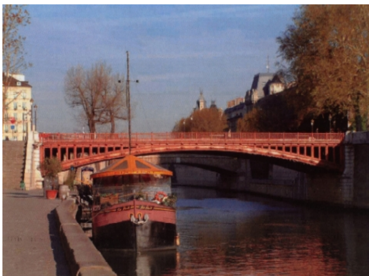
Vue générale du pont après restauration et patine.
