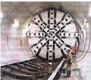
Europa, tunnelier T2 utilisé pour le forage de la galerie ferroviaire nord. On distingue nettement la tête de forage.
