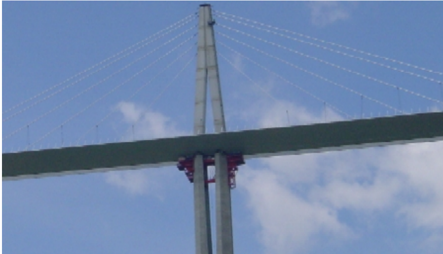
Les pylônes et le tablier ont nécessité l'utilisation d'acier thermomécanique S460 ML (D.R.)
