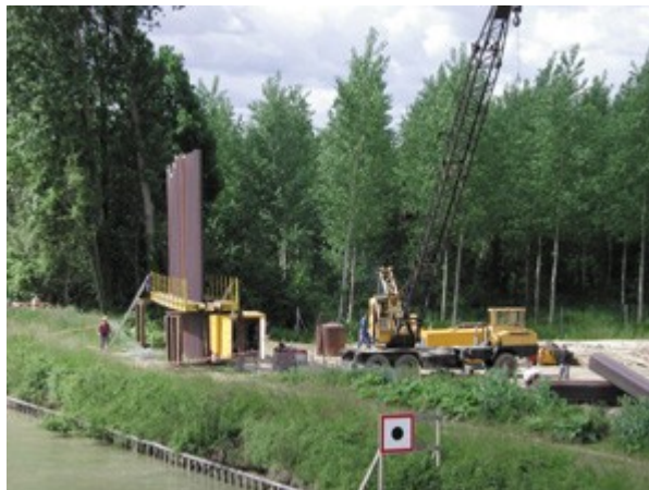
(Construction des appuis en bord de Marne)
