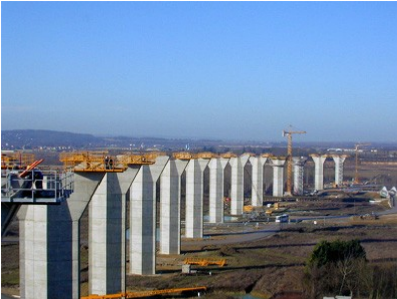
(Une vue des piles en construction)
