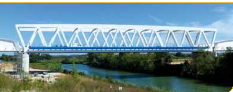
Viaduc du Vidourle (Warren métallique)
