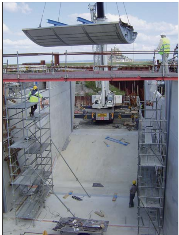
Photos 5 et 6 Montage du tablier Gate leaf erection
