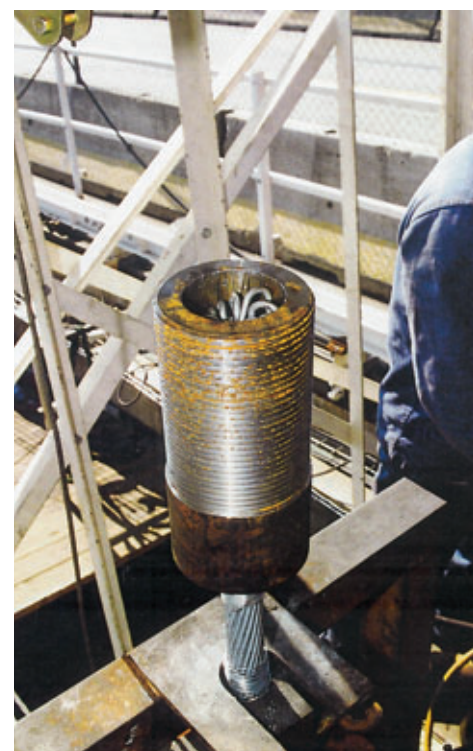
Photo 6 Culot d'ancrage de câble porteur avant coulage de zinc
