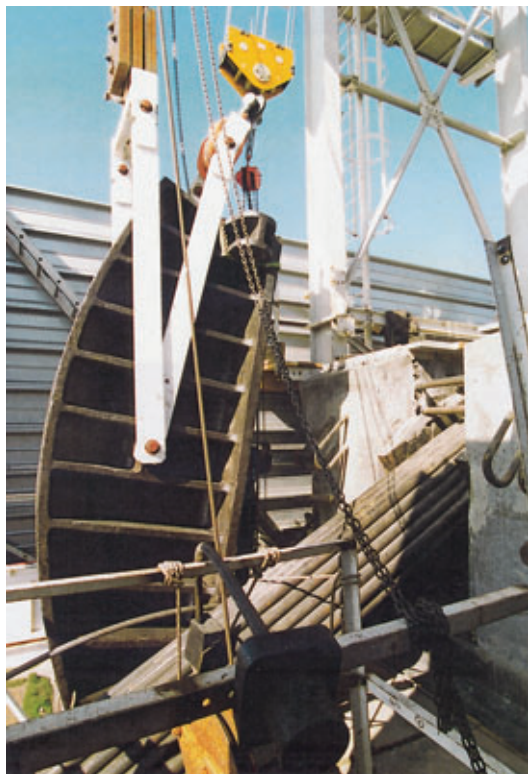
Photo 3 Levage d'une selle de déviation en tête de pylône. Arrivée en tête avant rotation de 90° et pose Lifting a deviation saddle to the top of the tower. At the top, before 90° rotation and placement
