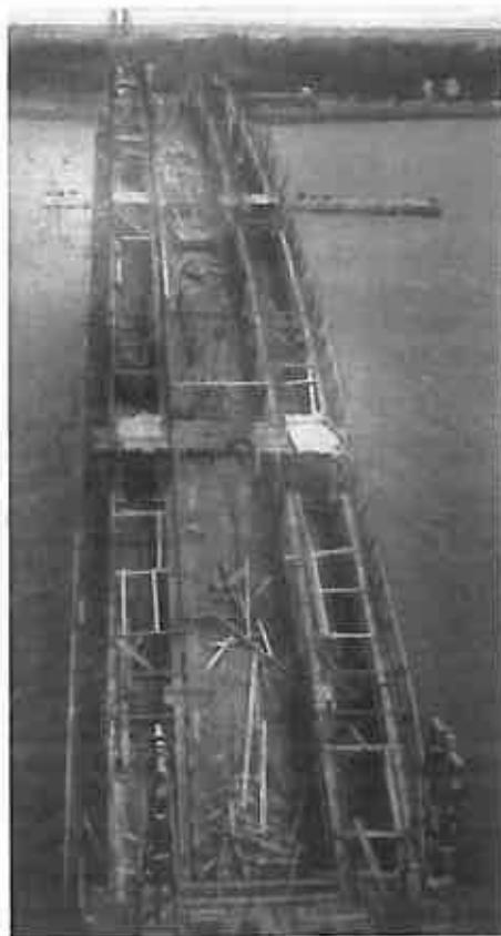
fig. 21 – 7.06.1928. Le bétonnage du premier arc vu d'oiseau. 7.06.1928. Casting the first arch. Bird's-eye view.
