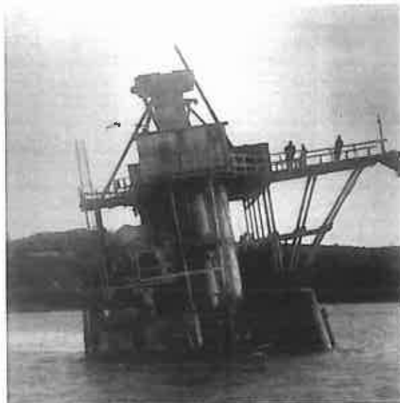
fig. 12 – 4.01.1927. 4.01.1927. The caisson Le caisson incliné à 14% sur la Basse du Prince Russe.
