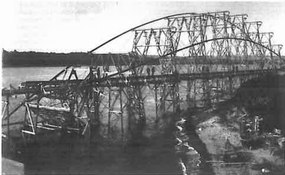
Fig. 14 — 13.05.1927. Construction du cintre sur la berge.
