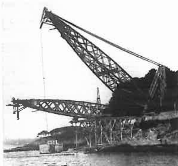
fig. 7 – 4.06.1926. Même opération côté Brest. 4.06.1926. Same operation on the Brest side.
