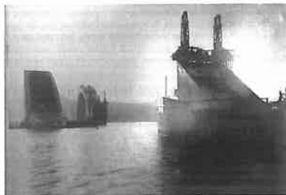
fig. 22 – 19.01.1929. Après bétonnage des deux premiers arcs, le cintre vogue vers sa troisième position. 19.01.1929. After the casting of the first two arches, the centring moves towards its third position.
