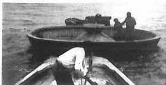
Fig. 16 — 19.08.1928. Mise en place d'un caisson pour l'amarrage du câble permettant l'acheminement du cintre.
