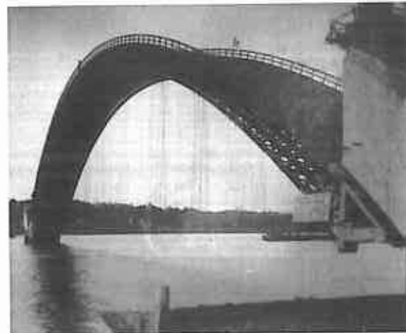
fig. 18 et 19 2.04.1928. Le cintre est hissé par la marée sur les naissances des arcs.
