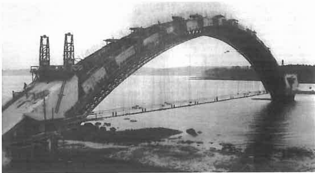
fig. 20 – 6.02.1928. Le bétonnage du premier arc. 6.02.1928. Casting the first arch.
