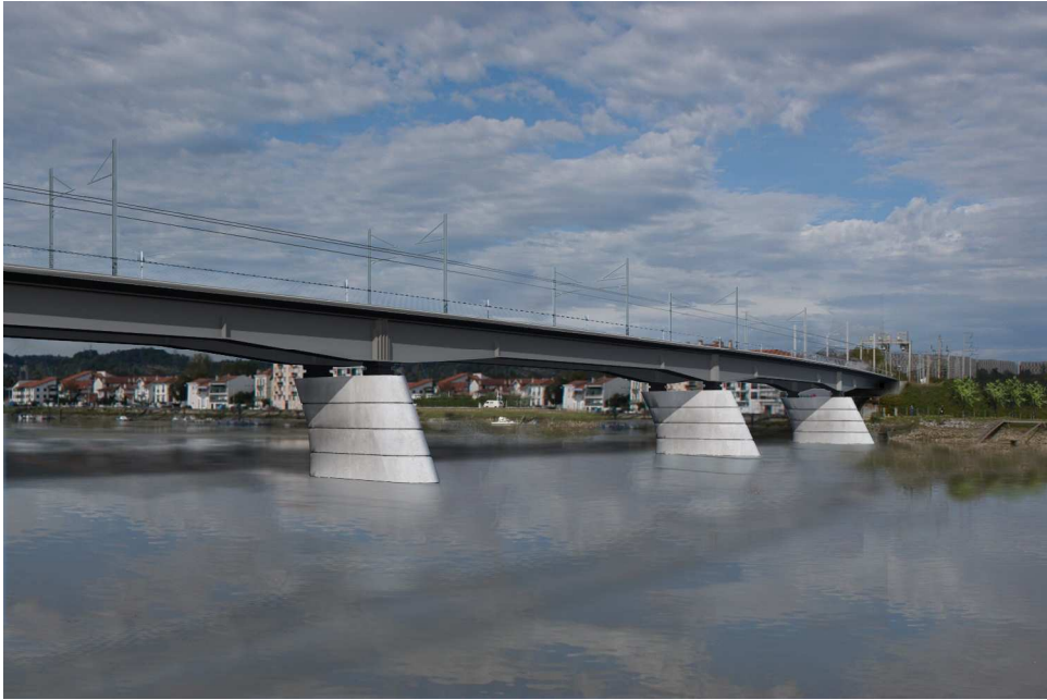
Viaduc ferroviaire sur l'Adour
