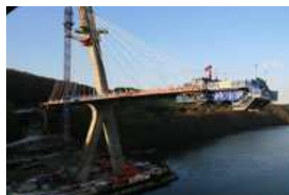
Chantier du nouveau pont
