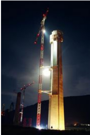
Le 12 juin 2003 au soir, à l'occasion du Record Mondial de hauteur de pile, le chantier du viaduc de Millau a fait la fête. (photo Eiffage)
