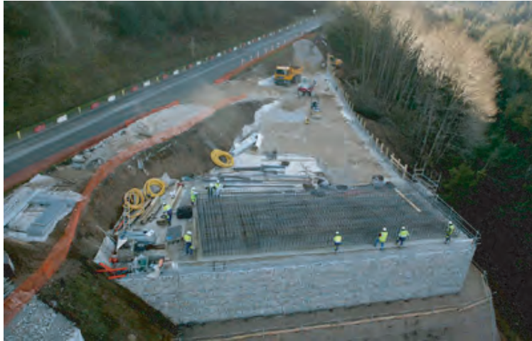
Construction du tablier à partir de la rive.
