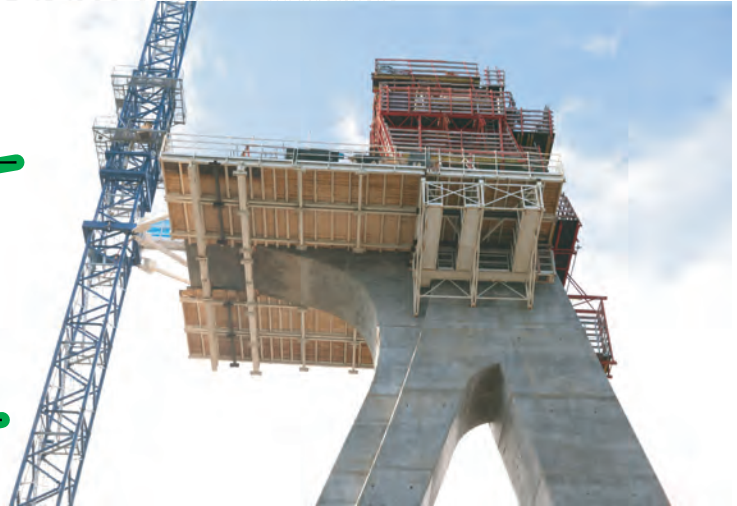
Premier voussoir, au niveau du noeud du pylône
