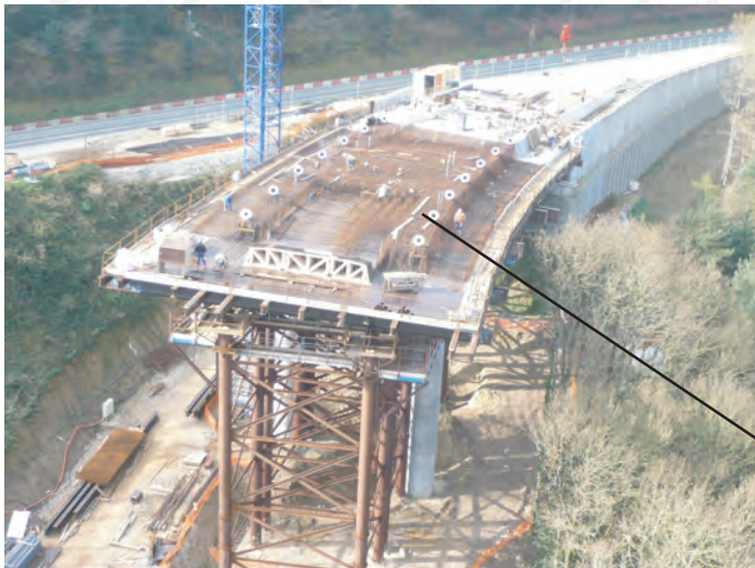
Ferrailage du tablier avant bétonnage.
