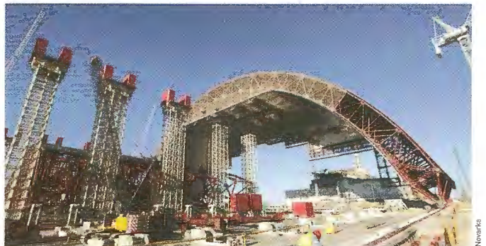
Avril 2014 : ripage première moitié vers zone d'attente et levage seconde moitié.
