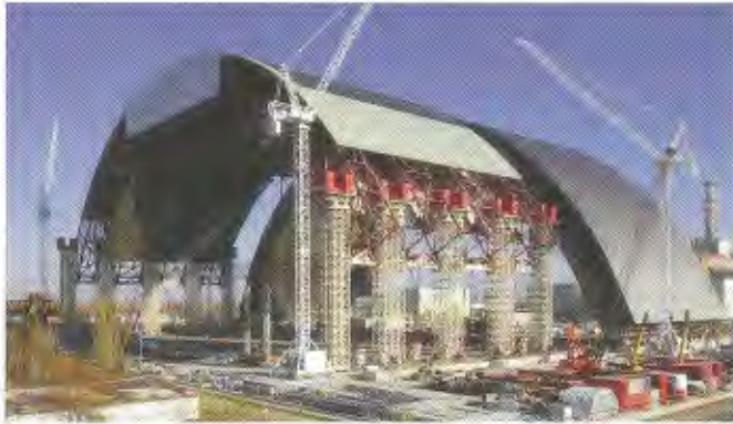
Octobre 2014 : troisième et dernier levage de la seconde moitié de l'arche.
