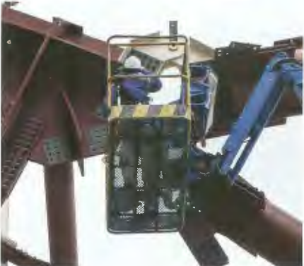
Novembre 2012 : opération de levage de l'arche.
