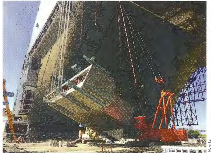
Mai 2015 : levage d'une des portes d'étanchéité (tilting panel).
