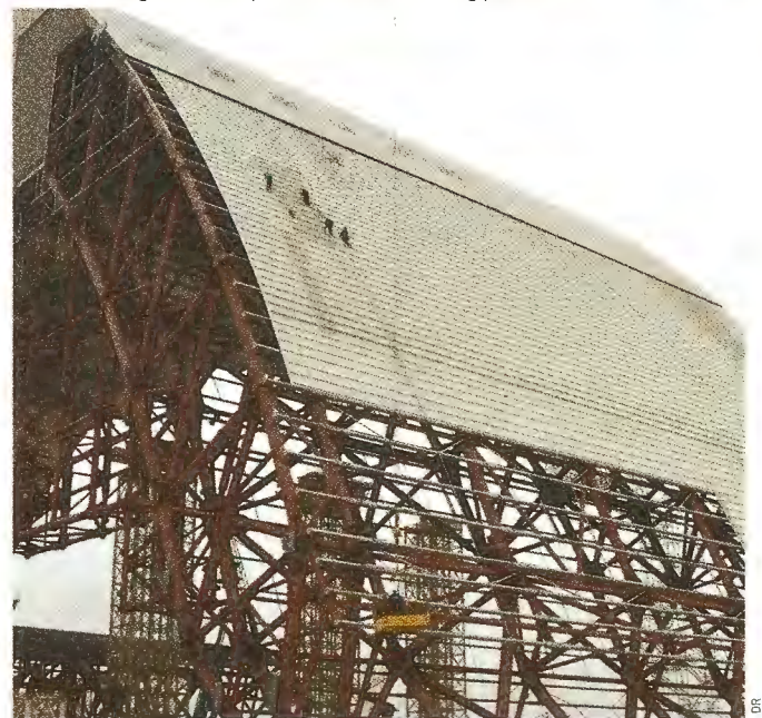
Pose du bardage extérieur.
