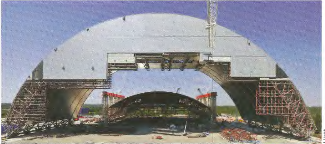
Août 2014 : deuxième levage de la seconde moitié de l'arche.
