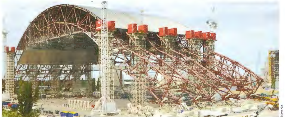
Juin 2013 : deuxième opération de levage.
