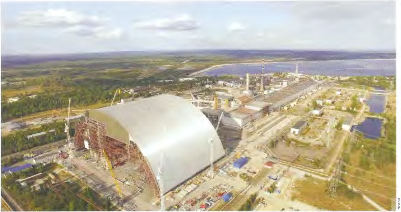
Octobre 2015 : connexion des deux moitiés d'arche.
