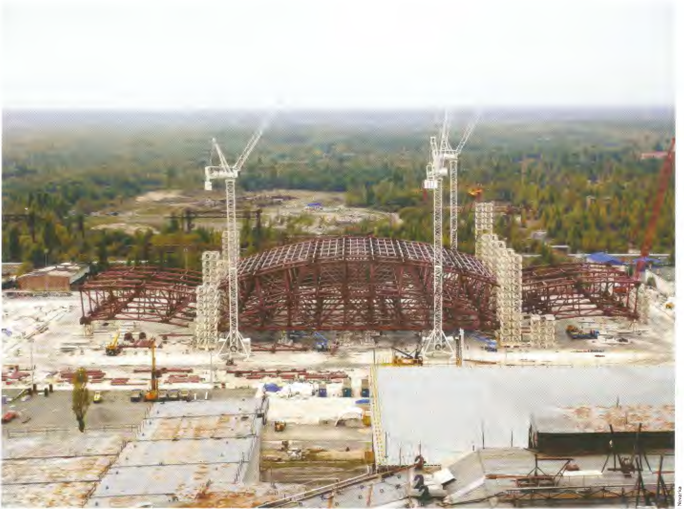
Octobre 2012 : montage de la première partie de la charpente.
