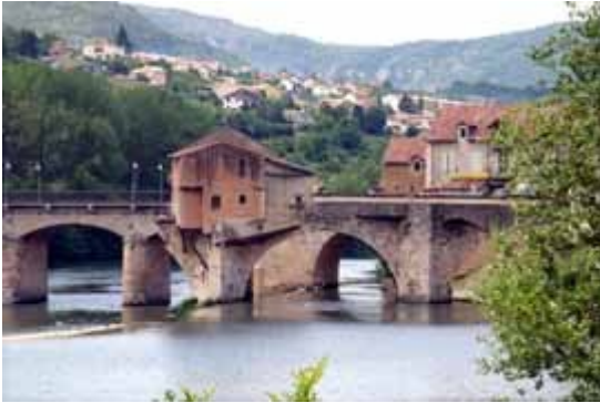
Le vieux pont de Millau appelé pont Lerouge (photo ASCO-TP)
