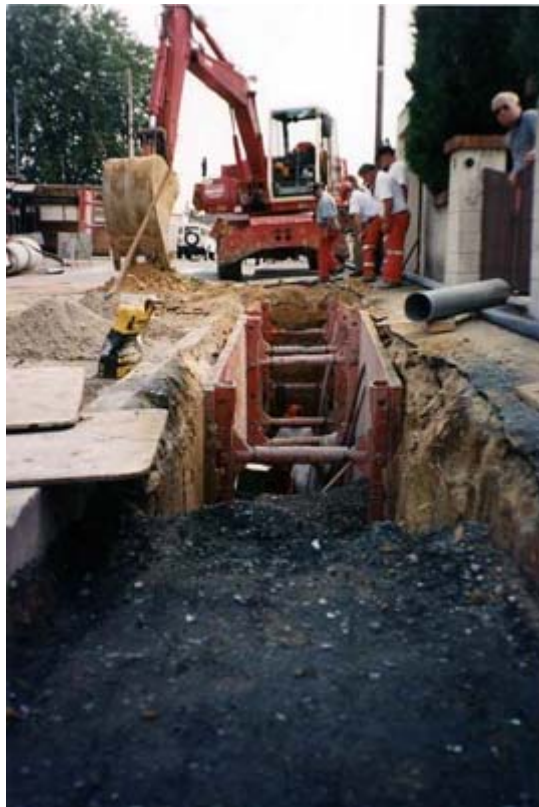
Utilisation d'une écograde en remblaiement de tranchée
