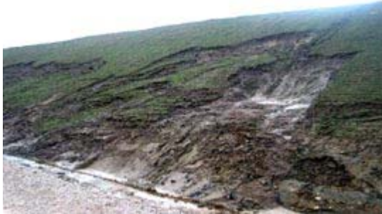
Talus instable = glissement (Droits réservés)
