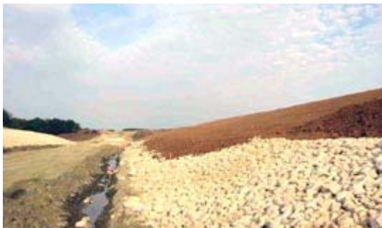
Confortement (Droits réservés)
