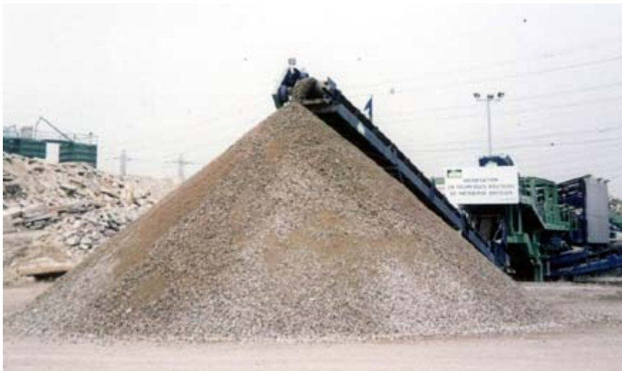
Station de concassage du béton de démolition et fabrication de grave recyclée
