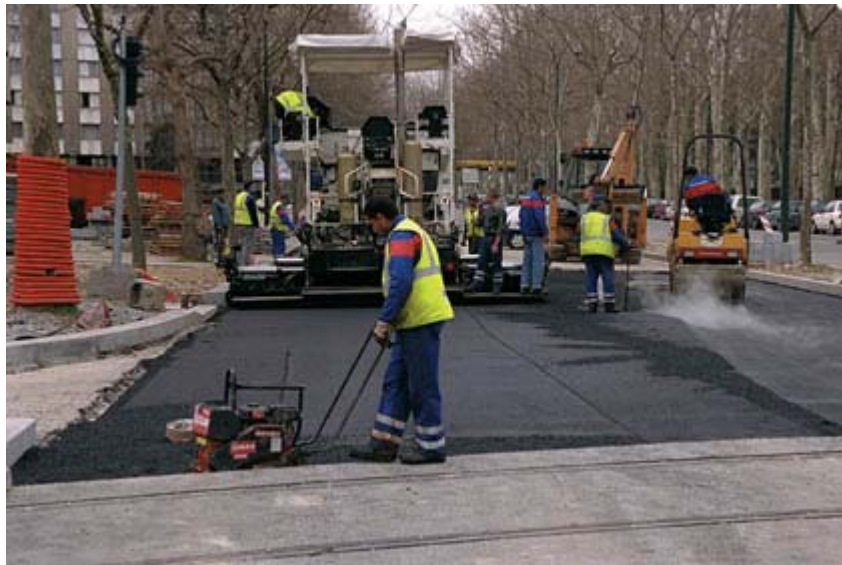
Chantier urbain (USIRF – Droits réservés)
