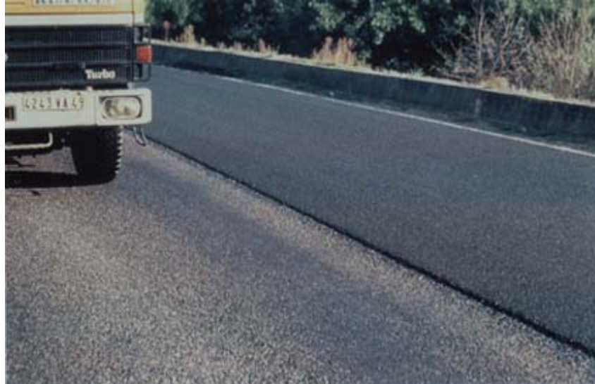
BBUM sur chaussée (USIRF)
