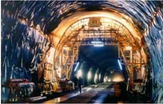
La mise en place d'un revêtement étanche, avant le coulage, par dessous et ultérieurement, de la voûte en béton
