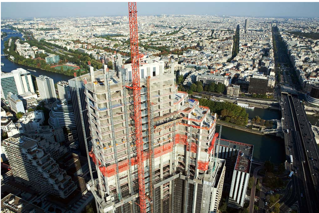
Chantier CB 31 (Photo : Bouygues Construction)
