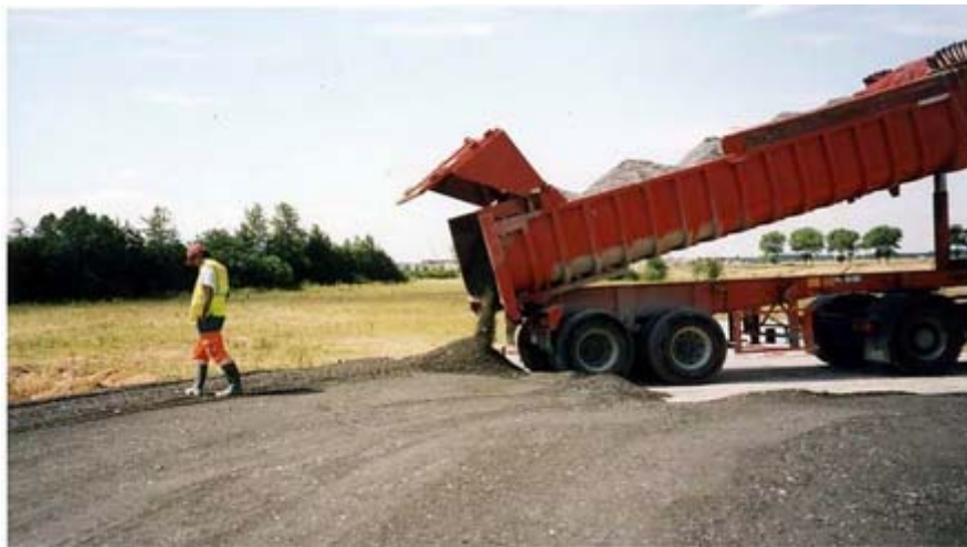
Mise en œuvre, en région parisienne, d'une grave-laitier issue du recyclage
