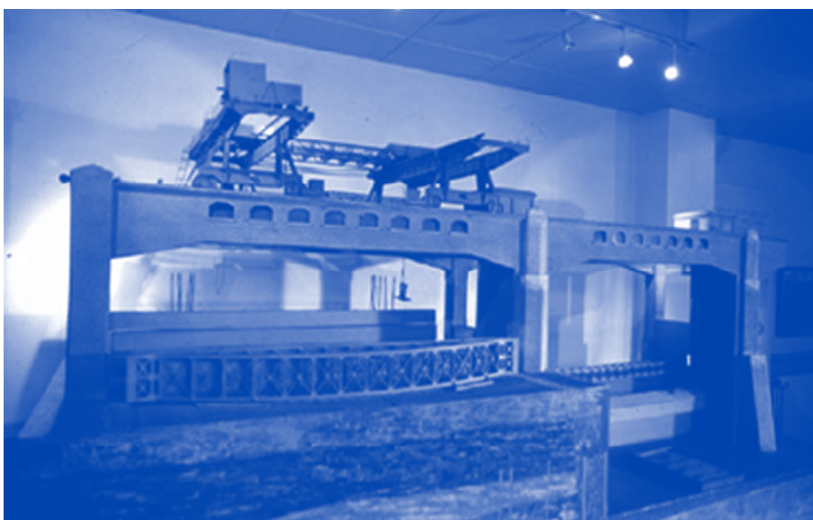
Deux travées du barrage de Chatou (Yvelines).
