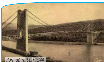
Pont détruit en 1944
