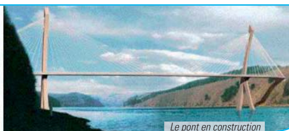
Le pont en construction
