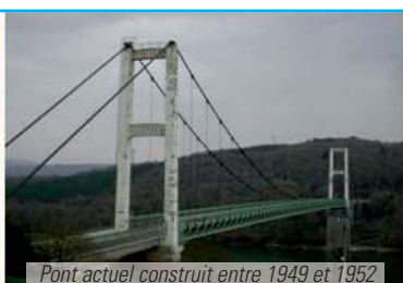
Pont actuel construit entre 1949 et 1952
