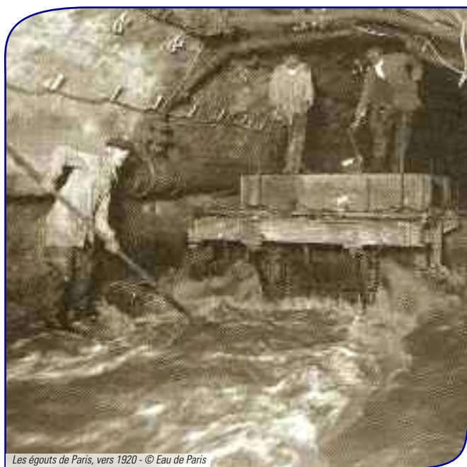
Les égouts de Paris, vers 1920 - © Eau de Paris
