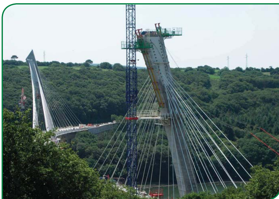
Le pont de Térénez en construction.
