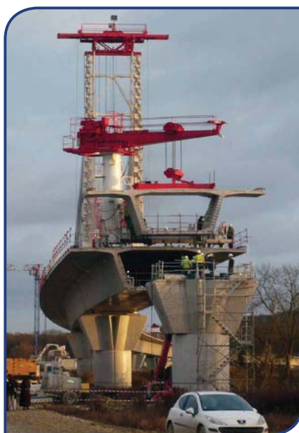
Le viaduc de Compiègne en construction.
