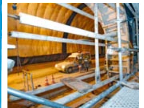
Débouché d'une galerie de secours dans le tunnel
