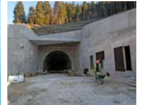
La tête amont sera revêtue de parements de pierres, pour une meilleure intégration au paysage
