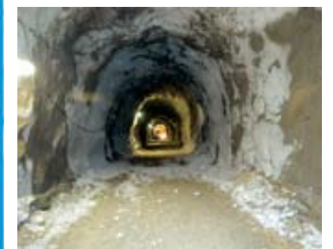
L'une des six galeries de secours
