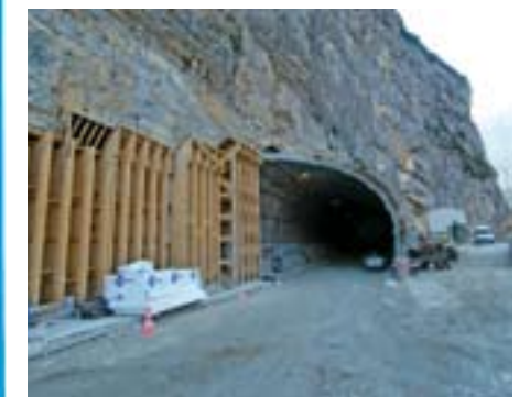
La tête aval sera elle aussi aménagée pour s'intégrer à l'environnement
