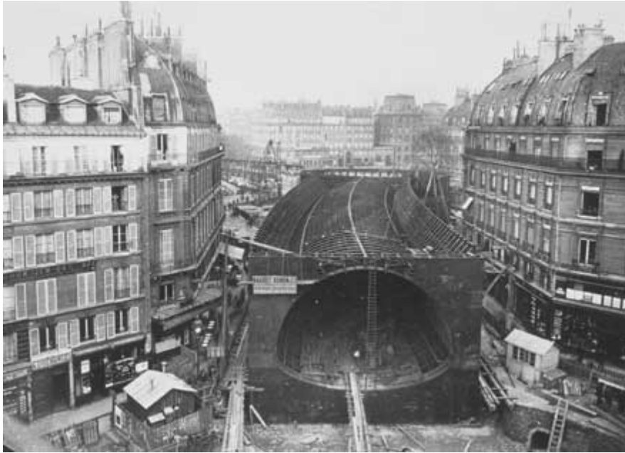
Ci-dessus la photo de la construction du métro de Paris au début du 20ème siècle. Il s'agit du caisson préfabriqué à l'air libre, puis descendu dans une tranchée, qui a été mis en oeuvre pour la construction de la station Saint-Michel du métro.
