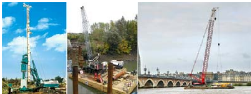
A gauche : Machine Casagrande Au milieu : Fondation de pont en Hongrie A droite : ducs d'Albe de protection d'un pont à Bordeaux (Doc. Balineau) (Droits réservés)
