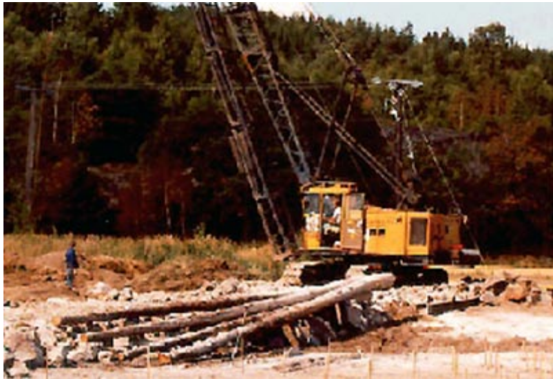
Pieux en bois (Droits réservés)
