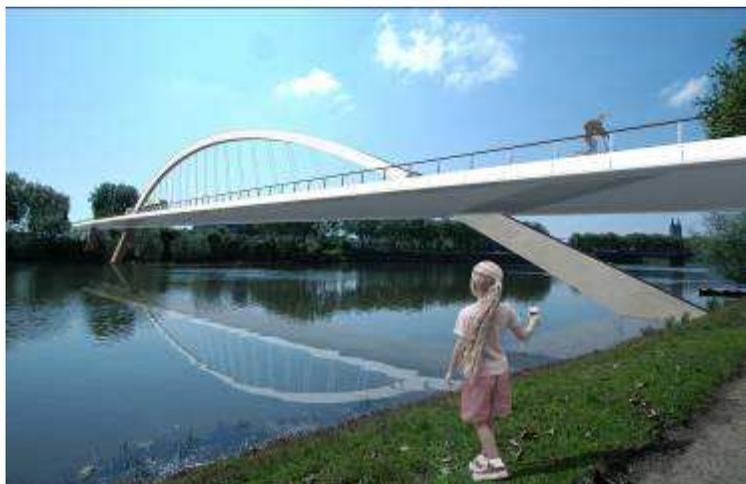
Le tablier est un caisson métallique à dalle orthotrope, d'une largeur de 17 m.
