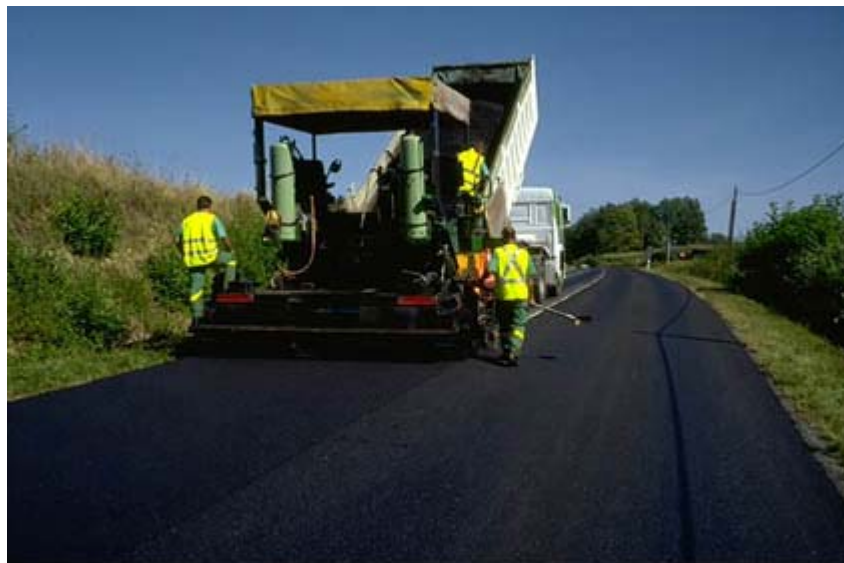
Enrobé à froid au finisseur (USIRF – Droits réservés)
