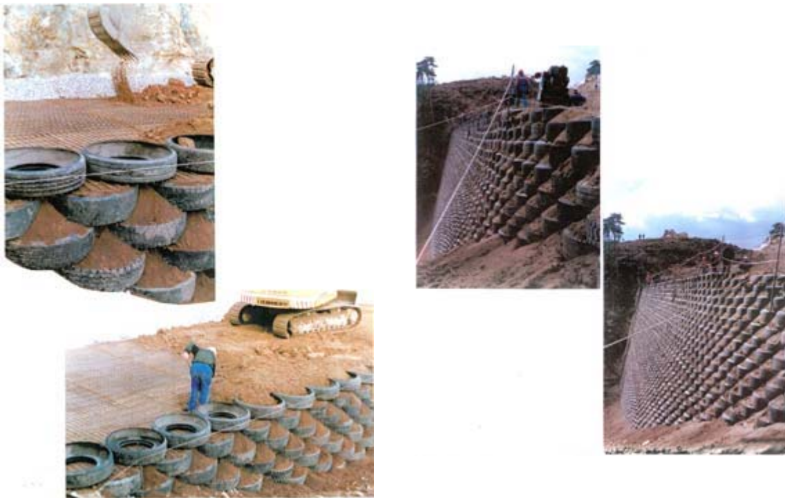
Massif renforcé selon le procédé Armapneusol qui associe des nappes de treillis soudés et des pneus en parement (Photo Forézienne d'entreprise).
