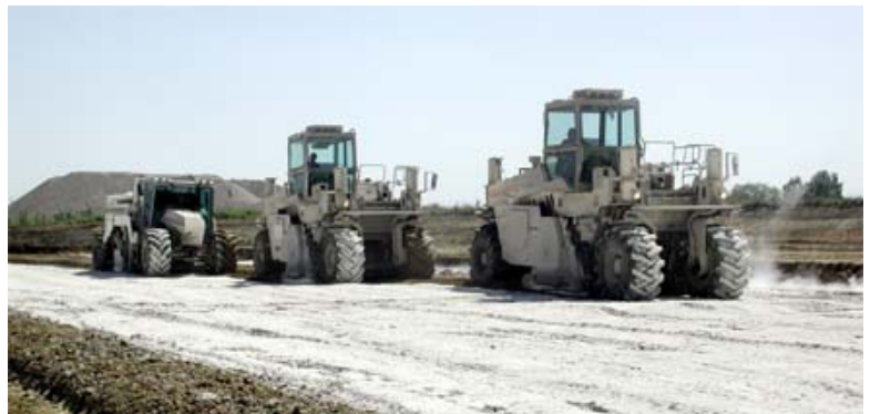
Mise au point d'une machine pour humidifier le sol en profondeur lors du traitement aux liants hydrauliques
