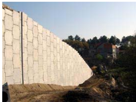
Remblai en terre armée terminé
