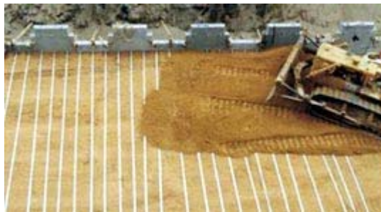
Pose des armatures longitudinales dans le remblai
