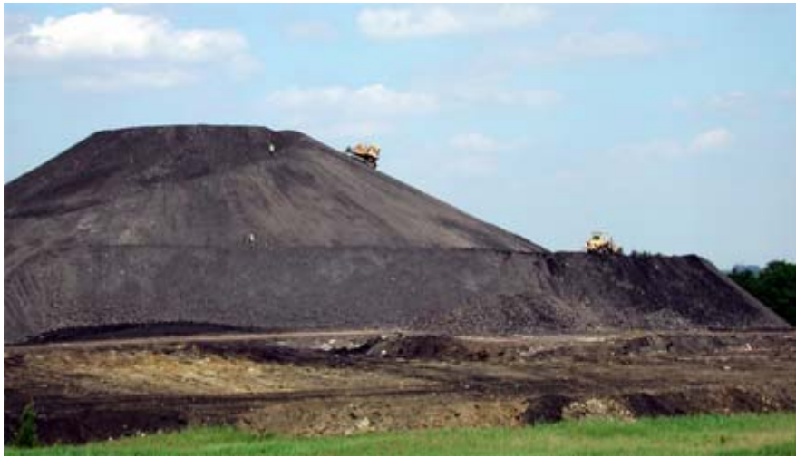
Réaménagement d'un terril
