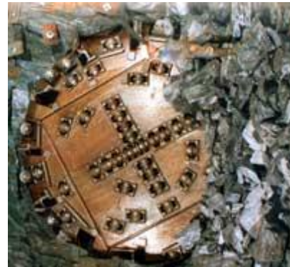
la tête fraiseuse du tunnelier, après qu'elle ait creusé une galerie d'évacuation d'eau du barrage de Grand-Maison, à l'instant où elle sort de terre. La précision du guidage souterrain est de quelques centimètres.
