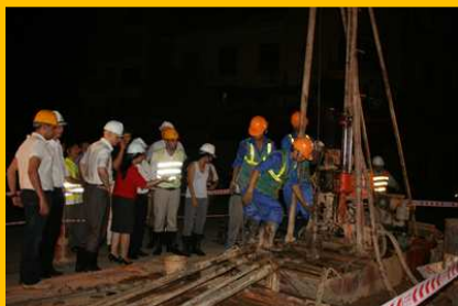
Travaux de forage devant la gare de Hanoi
