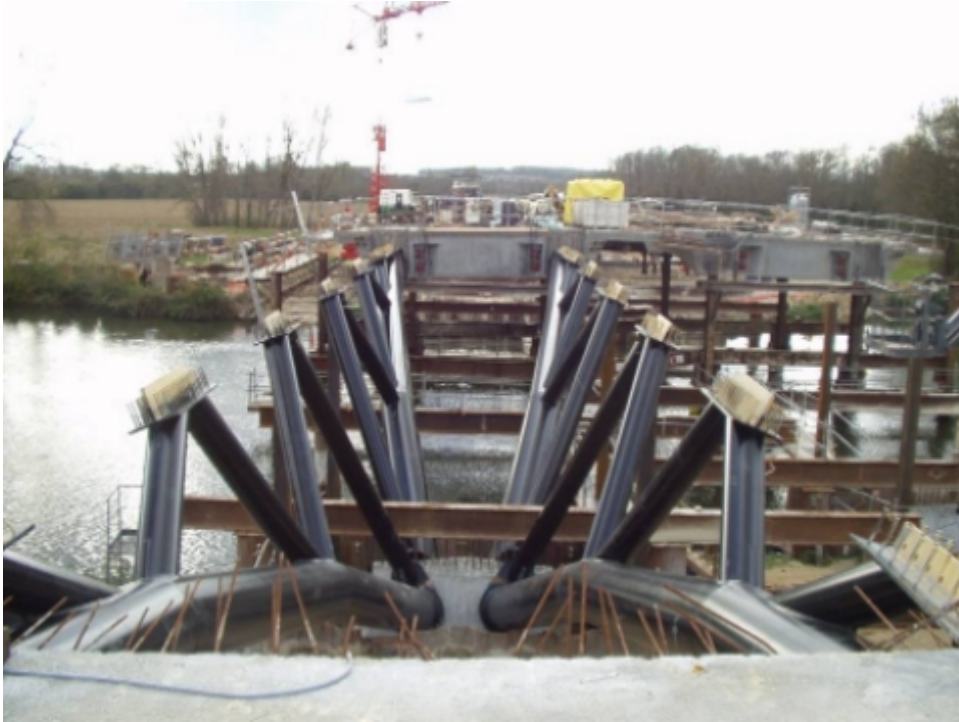
Montage de la structure tubulaire du tablier de Jarnac ( Ets J. Richard Ducros ) - D.R.
