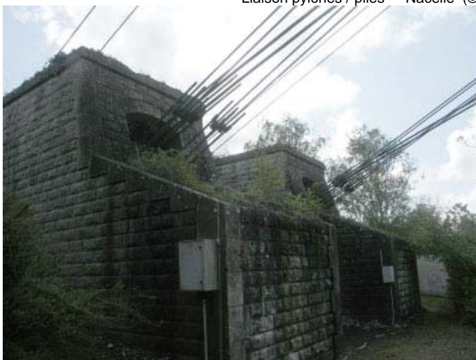
Culées d'ancrage Sud (© ASCO-TP)
