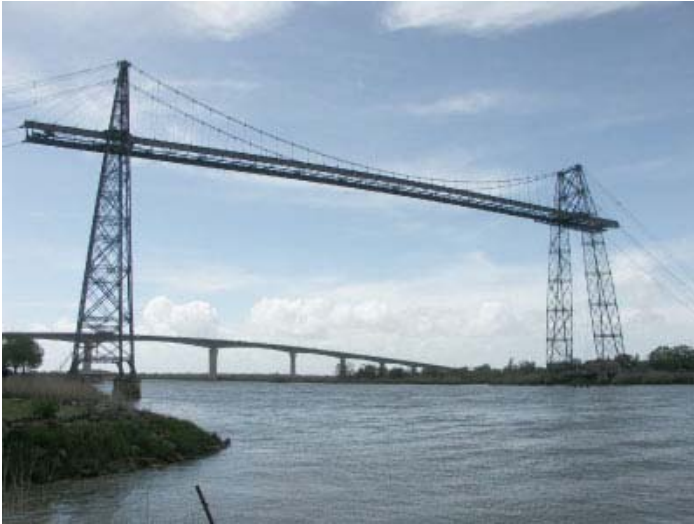
Pont transbordeur et le viaduc aval (© ASCO-TP)
