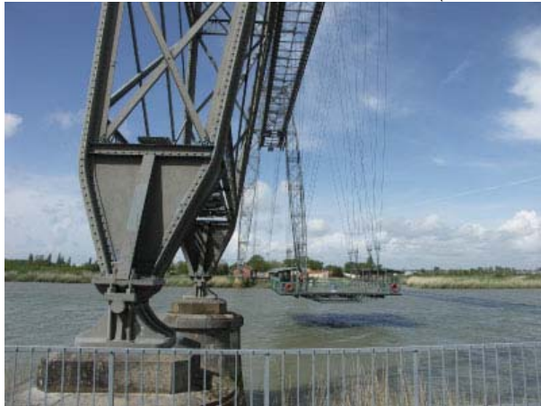
Liaison pylônes / piles - Nacelle (© ASCO-TP)
