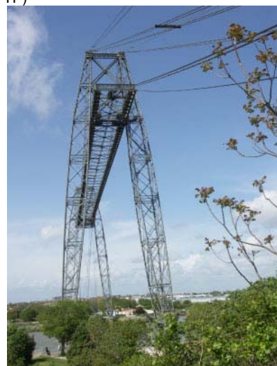
Vue depuis les culées d'ancrage Sud (© ASCO-TP)
